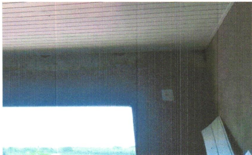
FOTO 02 – TOMADA ALTA DE EMBUTIR (1 MÓDULO), 2P+T 10A , INCLUINDO SUPORTE E PLACA -FORNECIMENTO E INSTALAÇÃO
