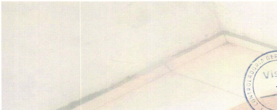
Foto 17- RODAPÉ CERÂMICO DE 7CM DE ALTURA COM PLACAS TIPO ESMALTADA EXTRA DE DIMENSÕES 45X45CM. AF_06/2014
