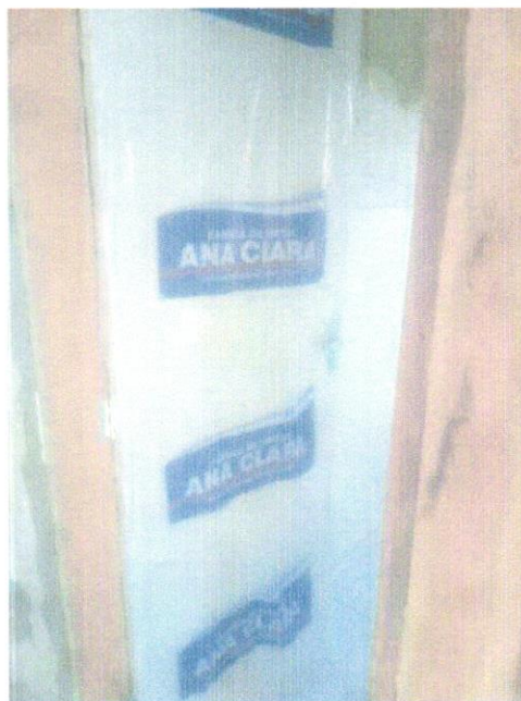
FOTO 04 - KIT DE PORTA-PRONTA DE MADEIRA EM ACABAMENTO MELANICO BRANCO, FOLHA LEVE OU MÉDIA 70X210, EXCLUSIVE FECHADURA, FIXAÇÃO COM PREENCHIMENTO PARCIAL DE ESPUMA EXPANSIVA – FORNECIMENTO E INSTALAÇÃO. AF 12/2019
