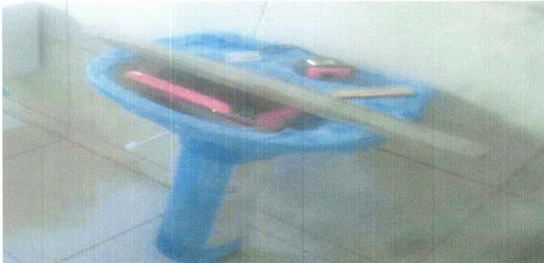
Foto 14 LAVATÓRIO LOUÇA BRANCA COM COLUNA, 45 X 55CM OU EQUIVALENTE, PADRÃO MÉDIO - FORNECIMENTO E INSTALAÇÃO. AF_01/2020
